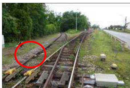
Bild 1: Radsensor nach einer Weiche
